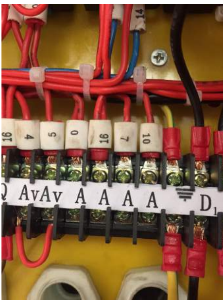
Fig. 7 – Tilslutning af fodsensor inde i kontrolpanelet
