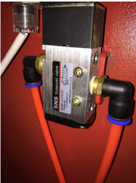
Fig. 4 - Tilslutning af luft inde i kontrolpanel
