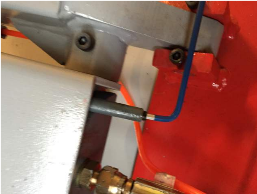
Fig. 15 - Udluftning af hydrauliksystem
